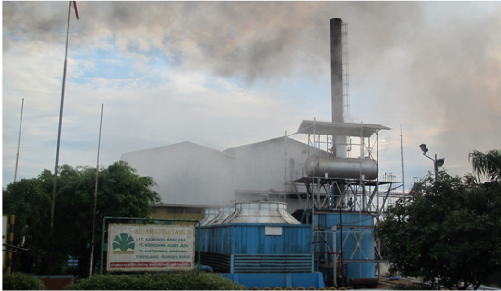
Gambar 5. Pembangkit Listrik Tenaga Uap Litrindo Kencana (Bangka) menggunakan bahan bakar limbah padat kelapa sawit (cangkang, fiber, dan janjang kosong).
