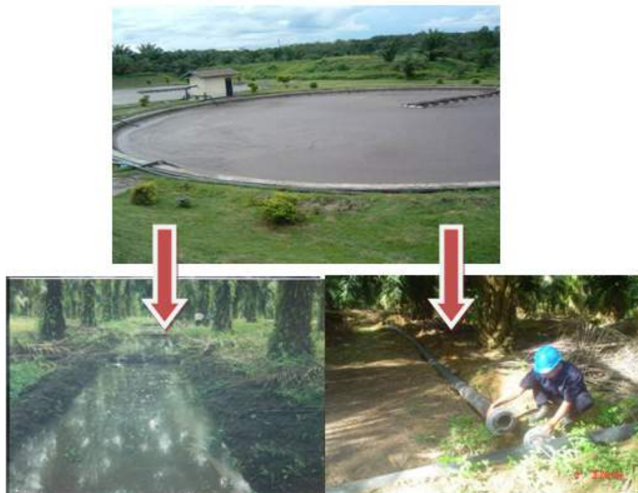
Gambar 8. Pemanfaatan air limbah kelapa sawit untuk mengairi kebun kelapa sawit ( land application )
