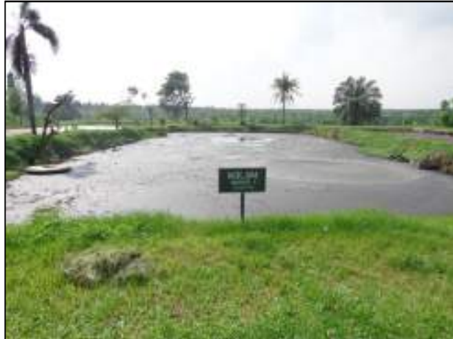
Gambar 4. Kolam Anaerob 1 UU Rejosari yang diusulkan untuk dipasang cover HDPE
