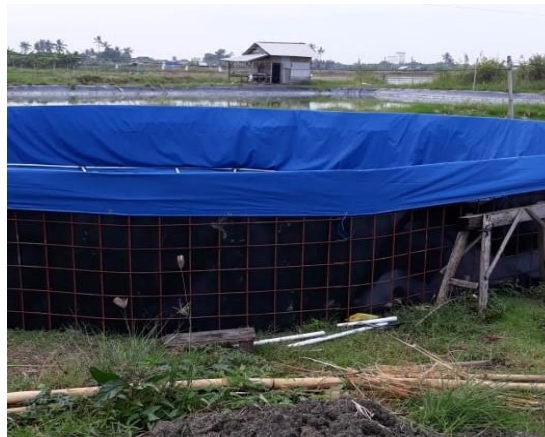
Gambar 4. Pemasangan Kolam Bundar D 8m.
