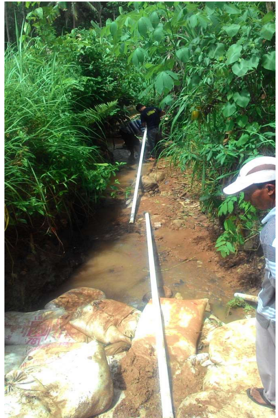
Gambar 6. Tim pelaksana mendemonstrasikan pemasangan komponen pipa suplai pompa tanpa motor.
