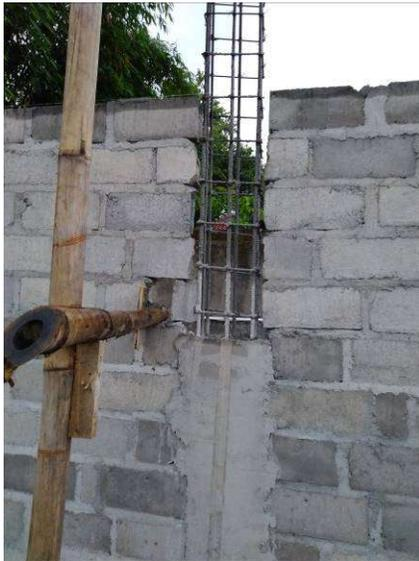
**Gambar 4.** Pemasangan dinding dan Kolom.
