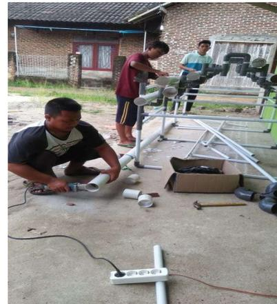
Gambar 5. Perakitan Instalasi Hidroponik.
