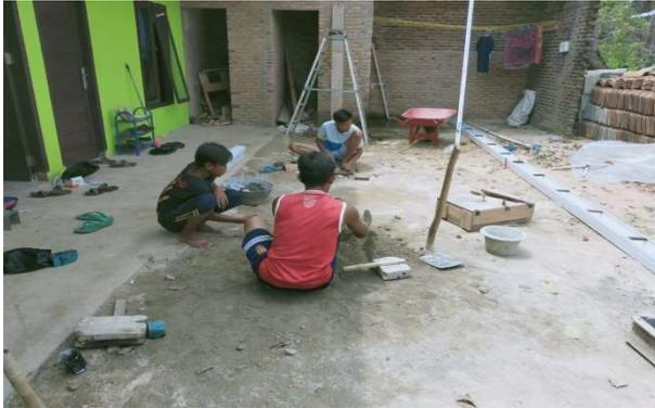
**Gambar 7.** Pembuatan Talang ke Tangki PAH.
