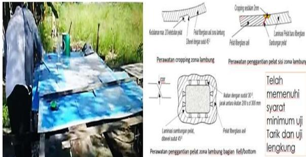
**Gambar 12.** Pelatihan *cropping*/penggantian pelat zona lambung fiberglass
