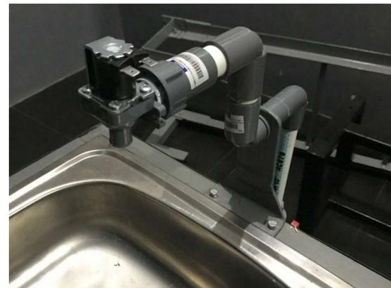
**Gambar 14.** Selenoid katup otomatis
