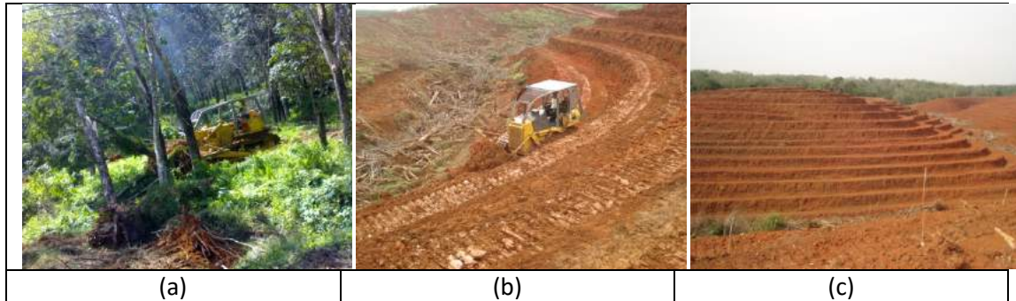
Gambar 2. LC tanam ulang (a), pembuatan teras (b), teras siap tanam (c)
