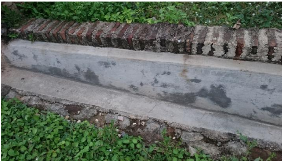
Gambar 5. Dinding dan dasar saluran dibeton
