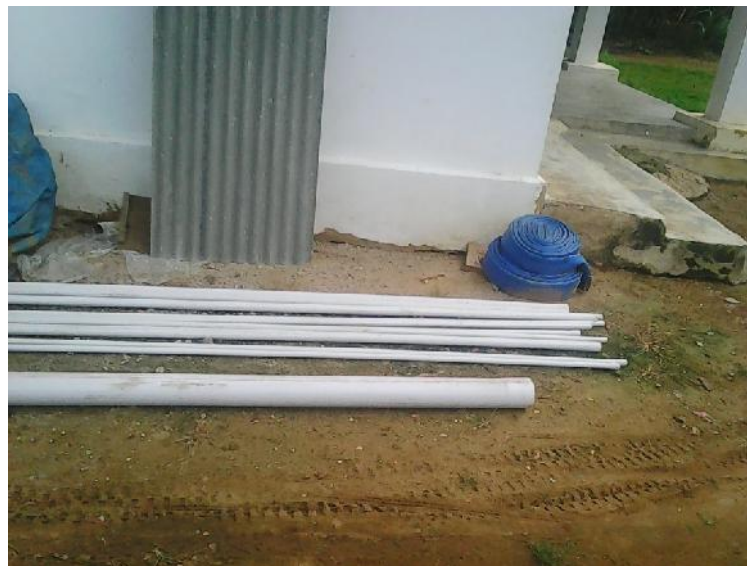
Gambar 4. Pipa untuk saluran pemasukan dan pengeluaran air
