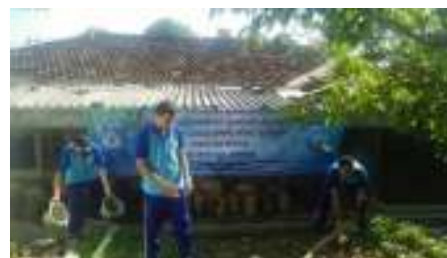
Gambar 7. Proses Pembangunan Teknologi
