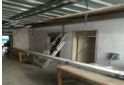
Gambar 9. Kondisi Pembangunan Teknologi yang Telah Terpasang 50%
