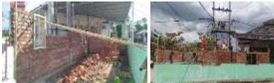
Gambar 2. Proses pembangunan di lokasi
