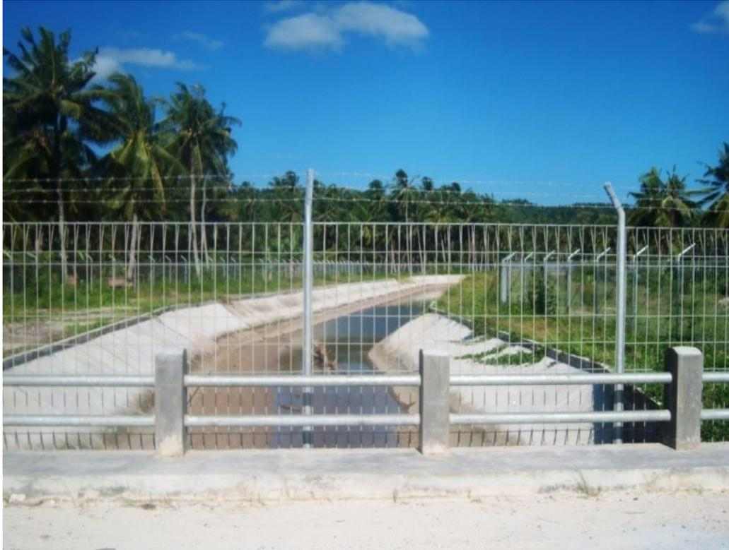
Gambar 2. Rencana saluran pembuangan (*outlet*) air panas yang dipakai sebagai pendingin mesin PLTU Sebalang
