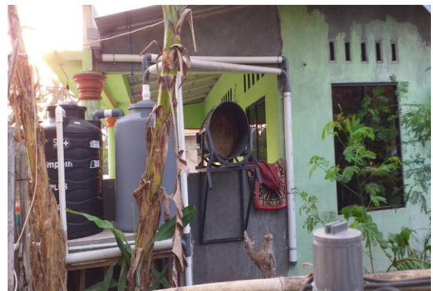
Gambar 5. Pemanenan Air Hujan di TPQ Darrul Islam.
