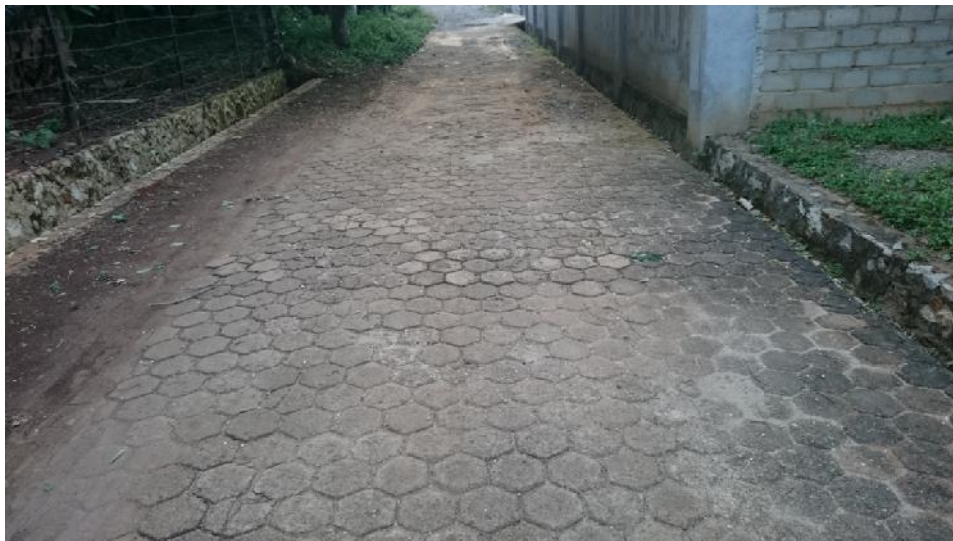
Gambar 3. Saluran drainase yang terletak di salah satu gang di Sindangsari
