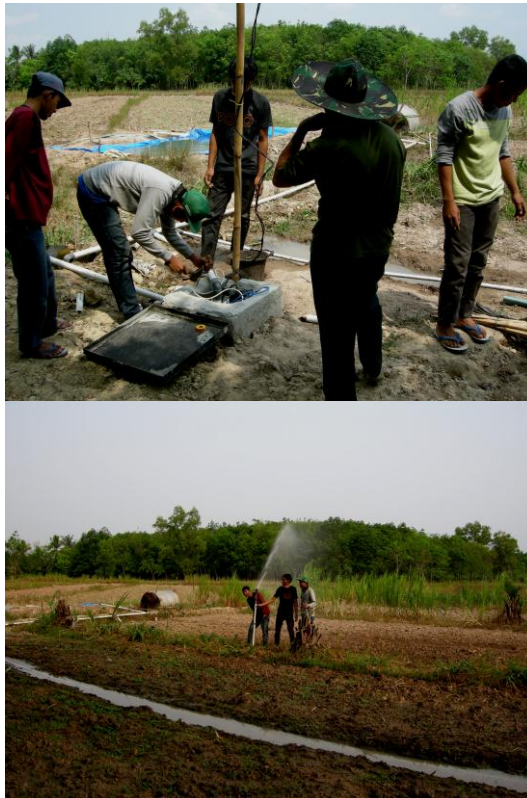
Gambar 4. Pemasangan dan uji-coba sprinkler
