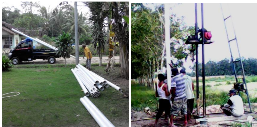
Gambar 3. Pengadaan pipa paralon dan pemasangan pompa
