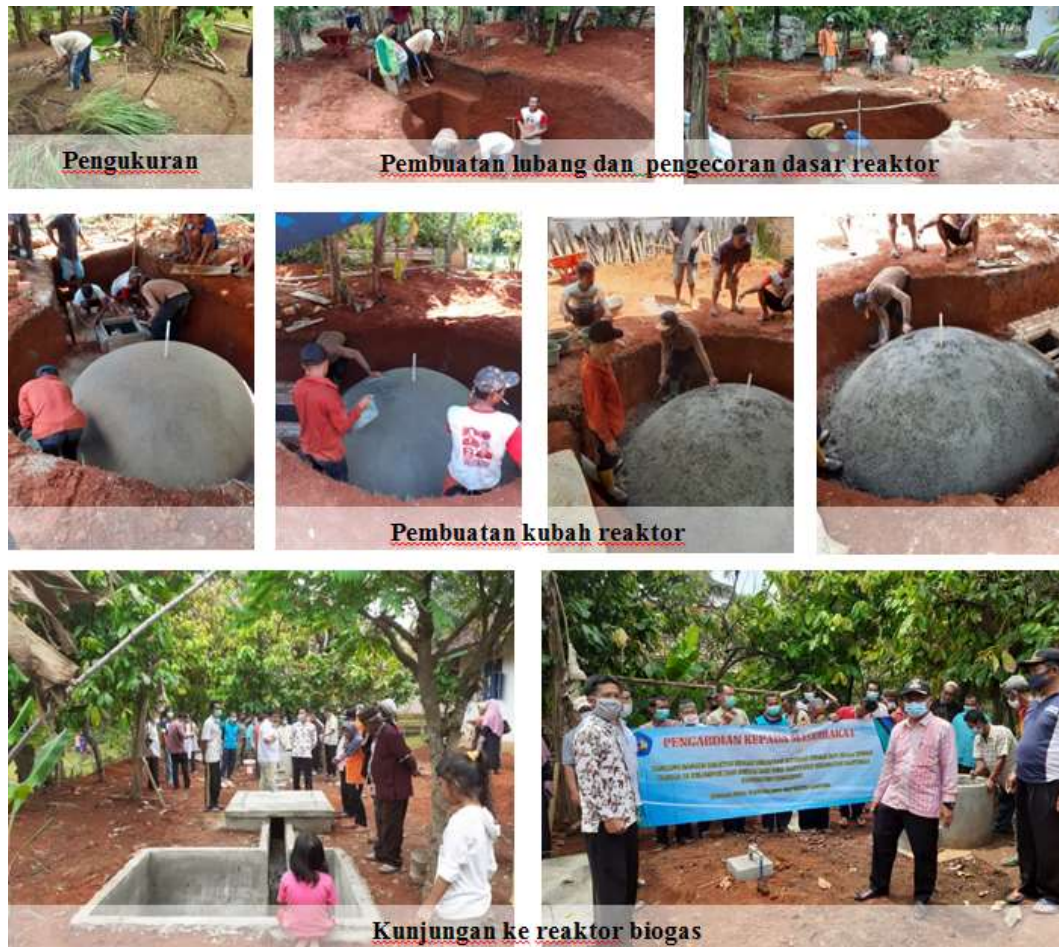
Gambar 3. Proses pembuatan reaktor biogas di Kelompok Tani Mekar Sari Desa Banyu Urip Kecamatan Banyumas Kabupaten Pringsewu.
