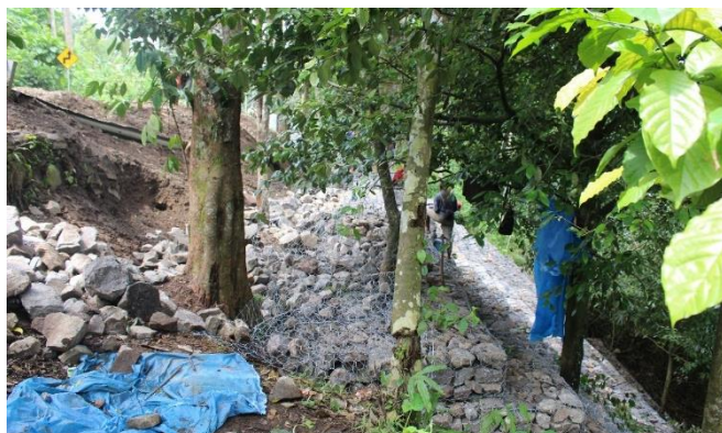
Gambar 2. Perkuatan dengan bronjong pada lereng bagian bawah badan jalan
