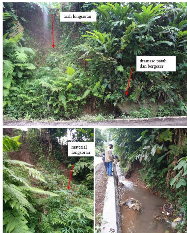
Gambar 7. Longsor di lereng bagian atas jalan Batu Keramat
