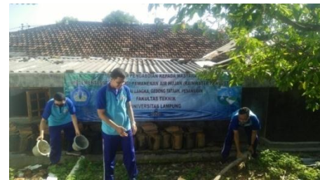
Gambar 7. Proses Pembangunan Teknologi
