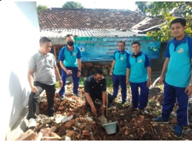
Gambar 6. Pembangunan Awal Teknologi yang Diresmikan Kepala Desa Sungai Langka
