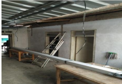
Gambar 9. Kondisi Pembangunan Teknologi yang Telah Terpasang 50%
