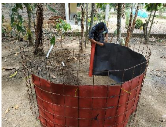
Gambar 2. Pembuatan Kolam Bioflok di KWT Bunda Jaya
