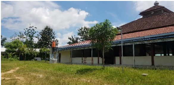
Gambar 3. Kondisi pada sisi kiri Masjid (Dokumentasi Survei)
