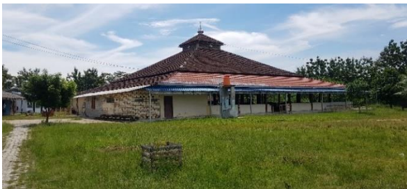
Gambar 4. Belum tersedianya toilet bagi Tamu Pondok saat kegiatan besar dilaksanakan (Dokumentasi Survei)
