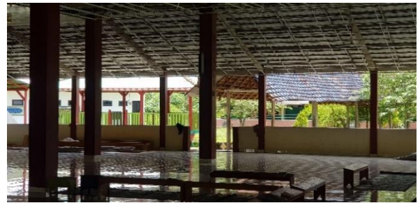
Gambar 6. Ketinggian dinding Masjid (Dokumentasi Survei)
