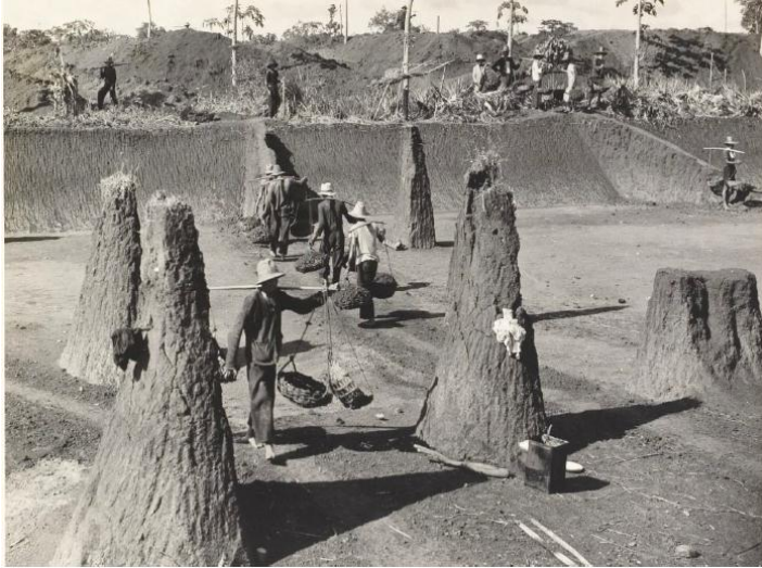
Gambar 3: Pembangunan Saluran Air di Bendungan, Untuk Irigasi Koloni Pertanian Jawa Di Metro, Distrik Lampung
