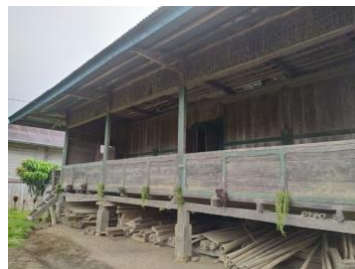
Gambar 2. Rumah milik Bapak Nas'ad (Sumber: Dokumentasi Pribadi)
