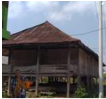
Gambar 1. Rumah milik Bapak Helmi (Sumber: Dokumentasi pribadi)
