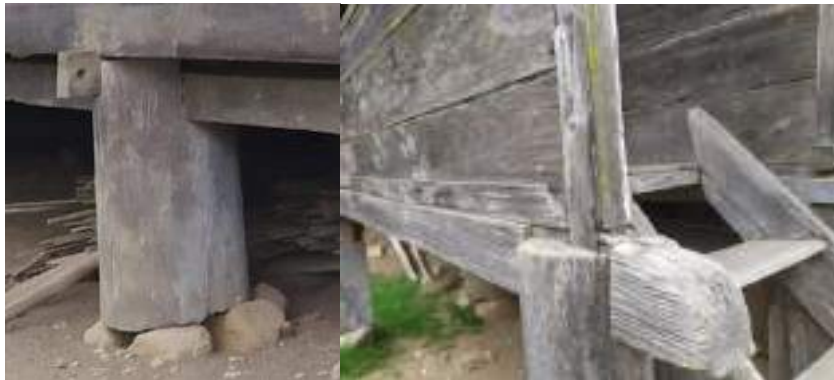
Gambar 9. Gambar Kolom rumah bapak Nas'ad (sumber: Dokumentasi Pribadi)
