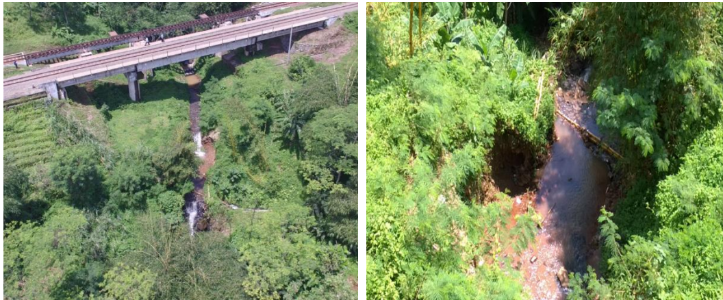
(a) Photo Udara BH. 364
