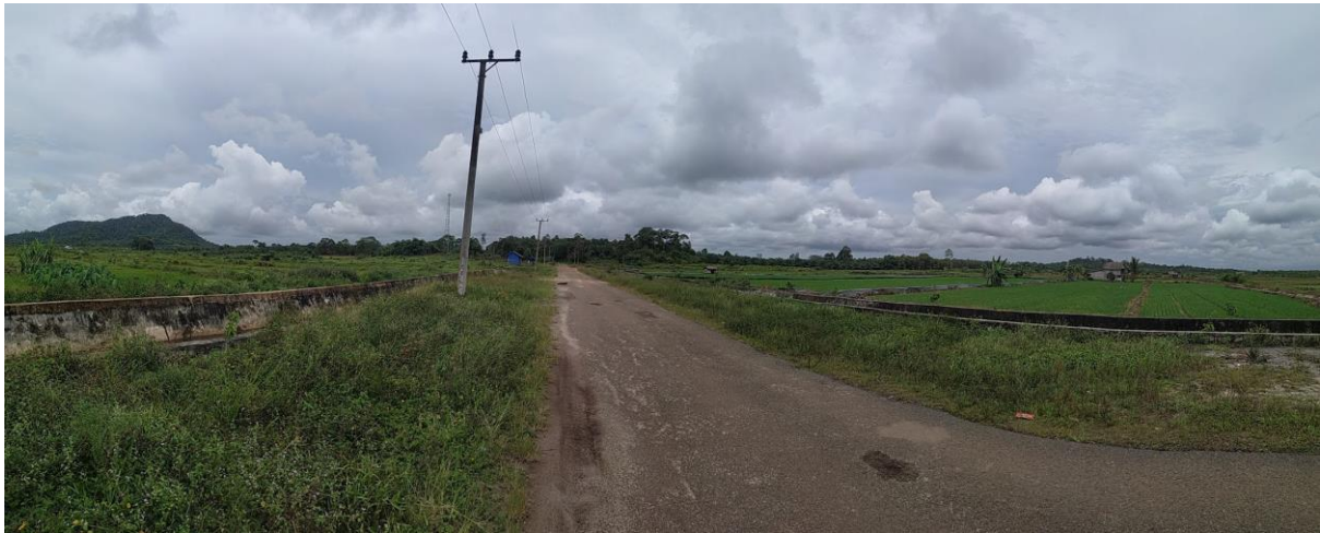
Kondisi Jalan Desa Pebuar
