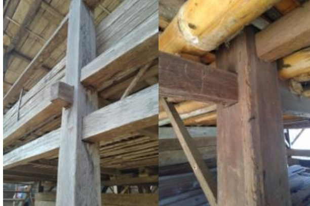
Gambar 8. Gambar Kolom rumah bapak Helmi (sumber: Dokumentasi Pribadi)
