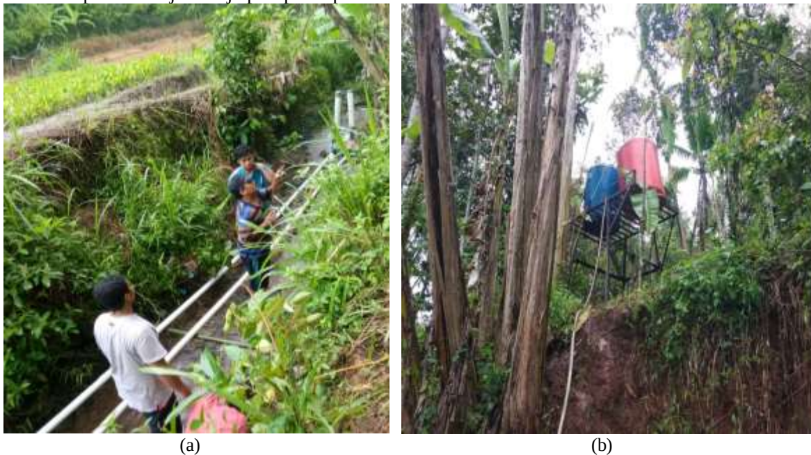
Gambar 5. (a) Pemasangan pompa tanpa motor ( hydram pump ) pada pembangunan sistem instalasi irigasi dilokasi. (b) Sistem irigasi pompa tanpa motor ( hydram pump ) yang dibangun.
