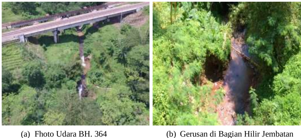
Gambar 1. Kondisi Eksisting Jembatan Kereta Api BH.364
