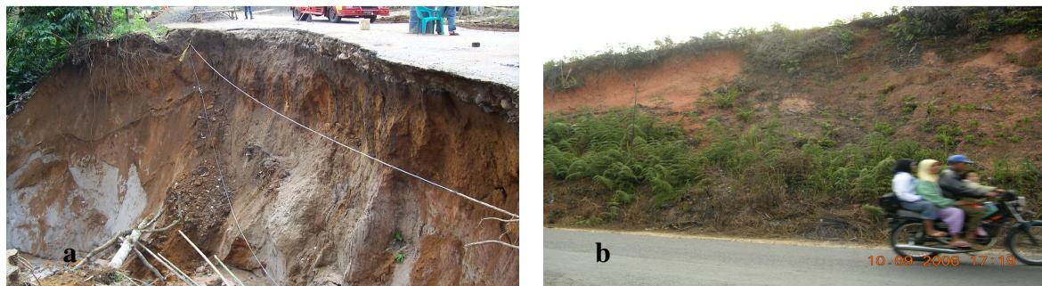
Gambar 4. a. Longsoran pada badan-jalan berupa batu pasir-tufaan,
