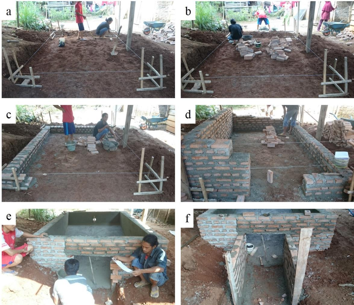
Gambar 13. (a-d) Foto-foto proses pembuatan ruang suplai udara panas dan zona pengeringan kakao, dan (e-f) foto-foto proses pembuatan ruang pembakaran kayu dan abu
