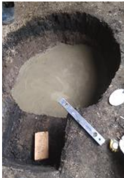
Penggalian Tanah Untuk Pembuatan Ruang Bakar Utama, dan Menarik Garis Sumbu, serta Pemasangan Batu bata Tahan Api Awal sebagai Lantai Dasar
