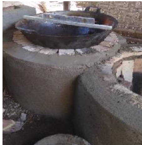
Ruang Bakar Kedua Telah Rampung, Dilanjutkan Pembuatan Cerobong Asap, dan Pengemalan Tempat Dudukan Wajan
