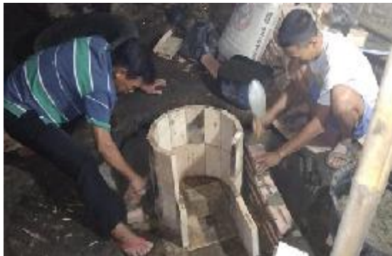
Gambar 3. Bata Tahan Api SK32 Disambungkan Antar Batu Tahan Api Menggunakan Castable.
