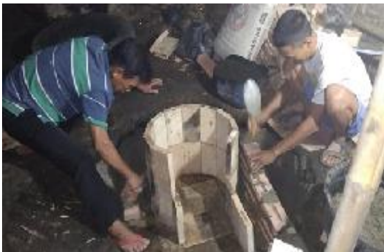
Batu Tahan Api SK-32 Dilubangi Untuk Penyambungan Antar Batu Tahan Api Menggunakan Castable. Ruang Bakar Utama Hampir Rampung
