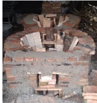
Gambar 4. Pembuatan Ruang Bakar Kedua dan Pemasangan Batu Bata Biasa Untuk Membuat Celah sebagai Isolator Rugi Panas Dengan Batu Bata Tahan Api SK32
