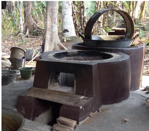
TUNGKU LAMA MITRA 2, tidak kokoh, retak & Pecah-pecah
