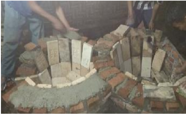
Pembuatan Ruang Bakar Kedua dan Pemasangan Batu Bata Biasa Untuk Menutupi Batu Bata Tahan Api SK32, sebagai Isolator Panas
