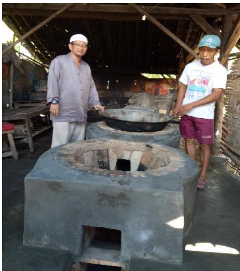
Ruang Bakar Kedua Telah Rampung, Dilanjutkan Pembuatan Cerobong Asap, dan Pengemalan Tempat Dudukan Wajan
