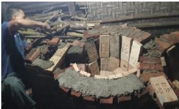
Ruang Bakar Kedua Telah Rampung, Dilanjutkan Pembuatan Cerobong Asap, dan Pengemalan Tempat Dudukan Wajan
