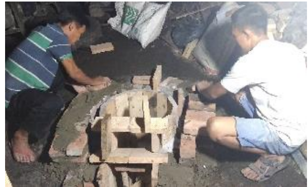
Batu Tahan Api SK-32 Dilubangi Untuk Penyambungan Antar Batu Tahan Api Menggunakan Castable. Ruang Bakar Utama Hampir Rampung
