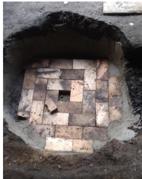
Penggalian Tanah Untuk Pembuatan Ruang Bakar Utama, dan Menarik Garis Sumbu, serta Pemasangan Batu bata Tahan Api Awal sebagai Lantai Dasar
