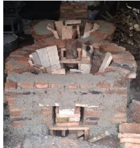
Pembuatan Ruang Bakar Kedua dan Pemasangan Batu Bata Biasa Untuk Menutupi Batu Bata Tahan Api SK32, sebagai Isolator Panas
