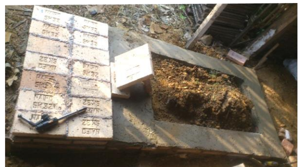
Pembuatan Pondasi Tungku sekaligus meninggikan posisi Tungku Penggorengan agar ergonomis, serta pemasangan Batu bata Tahan Api Awal
