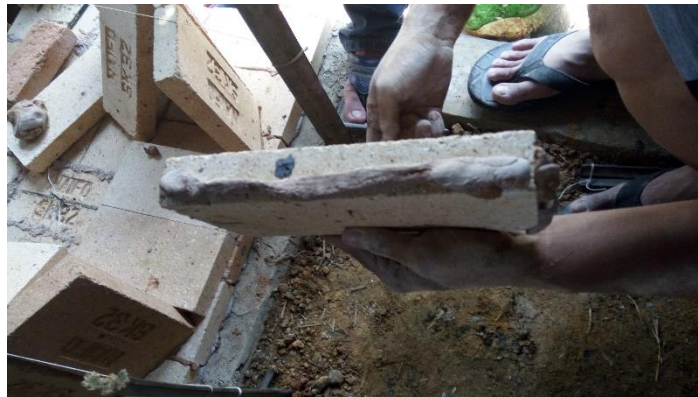
Pembuatan Ruang Bakar Utama Batu Tahan Api SK-32 Dengan diameter 65 cm. Selanjutnya dipanaskan menggunakan Gas Torch. Untuk Penyambungan Antar Batu Tahan Api Menggunakan Mortar dan Sodium Silikat.
