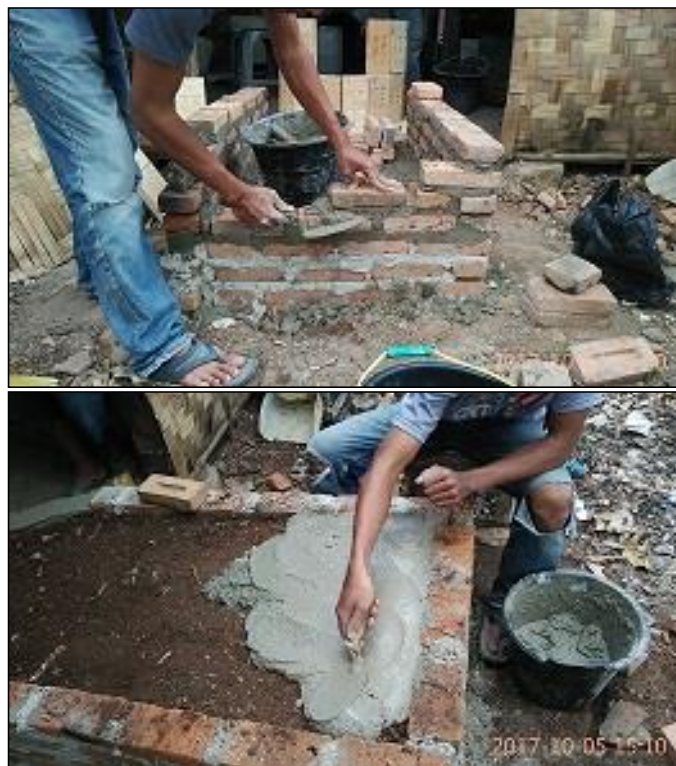
Gambar 7. Pembuatan dasaran lantai tobong belakang
