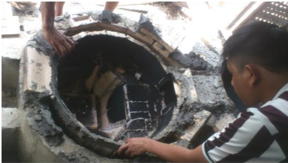
Pemanasan Ruang Bakar Utama Untuk Mengeringkan/ Memperkokoh Perekat Sambungan Yang Digunakan
