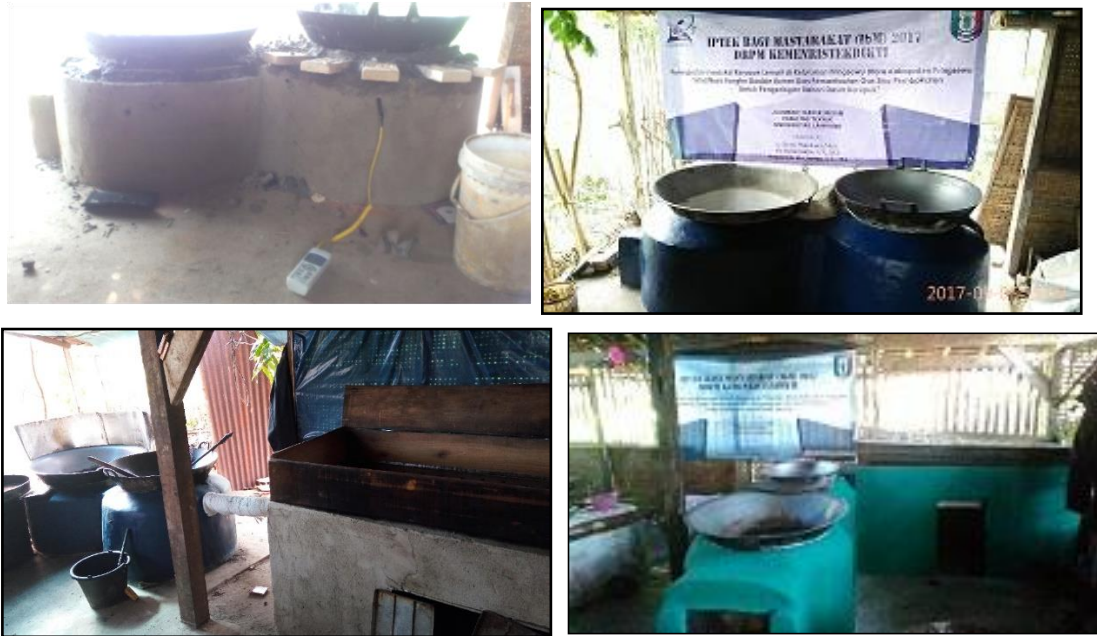
Gambar 4. Tungku Hemat bahan Bakar dan Kokoh Berbahan Dasar Bata Tahan Api SK32, Saat Pembuatan dan Tungku siap pakai
