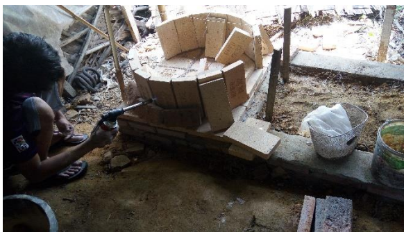
Pembuatan Ruang Bakar Kedua dan Pemasangan Batu Bata Biasa Untuk Menutupi Batu Bata Tahan Api, sebagai Isolator Panas
