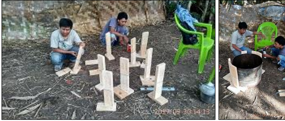
Gambar 3. persiapan dinding untuk tobong depan dari sambungan dua buah bata tahan api SK32 Ket : penyambungan bata tahan api dengan perekat semen tahan api bercampur sodium silikat, setelah penyambungan perekat bata tahan api dibakar menggunakan gas torch .
