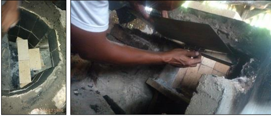
Gambar 12. Pemasangan dudukan kayu dan penutup lubang masuk kayu
