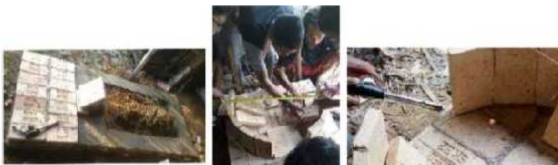
Gambar 3.2 Pembuatan Pondasi dan Lantai Dasar Tungku Bata Api SK32, Dinding Ruang Bakar Utama, dan Pemanasan Perekat Mortar-Sodium Silikat
