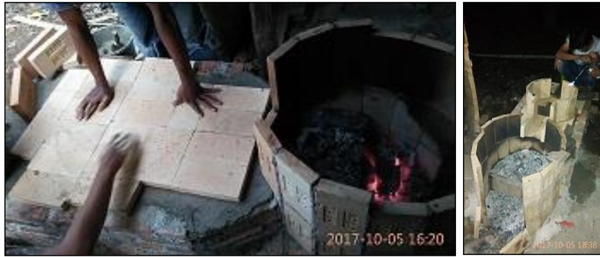
Gambar 8. Pembuatan lantai tobong belakang dan pembuatan dinding tobong belakang
