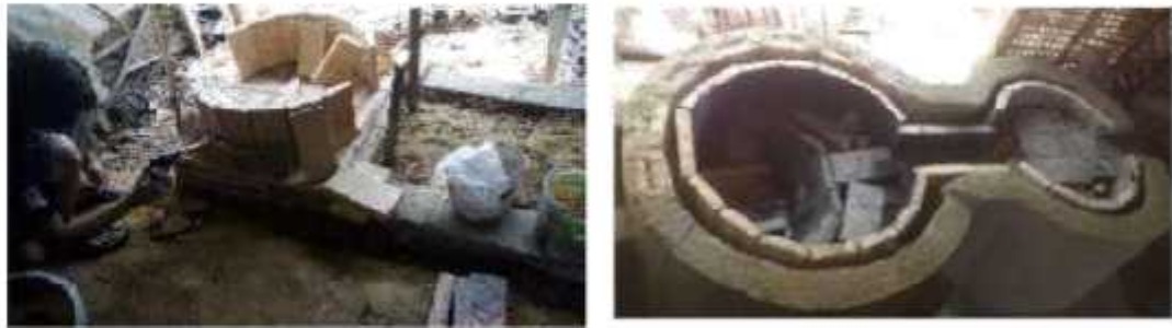
Gambar 3.3 Pemanasan Perakat Ruang Bakar Utama Menggunakan Gas Torch, Pembuatan Kemiringan Sudut Arah Semburan Kompor Solar dan Ruang Bakar Suplai, dan Pembuatan Celah Isolator Heat Losses Dengan Pemasangan Bata Merah Pada Dinding Luar
