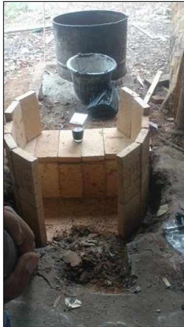
Gambar 6. Pembuatan lubang jatuhnya abu
