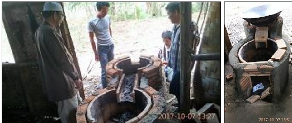
Gambar 10. Pembuatan dinding bata merah disekitar dinding bata tahan api SK32 dengan rongga kosong diantara keduanya
