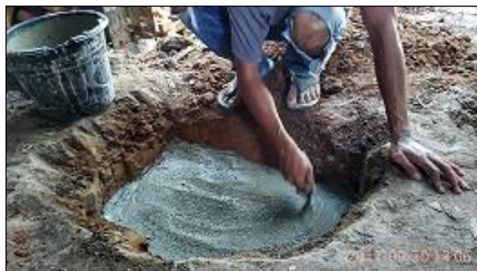
Gambar 2. Pembuatan fondasi tobong depan
