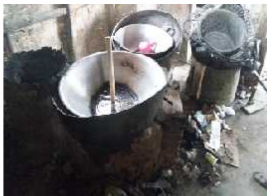
Gambar 2. Tungku yang retak tanpa cerobong asap yang layak, dan lingkungan kerja yang tidak nyaman dan tidak sehat
