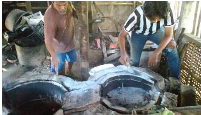
Gambar 13. Pengisian abu kedalam rongga kosong diantara dinding bata tahan api SK32 dengan dinding bata merah
