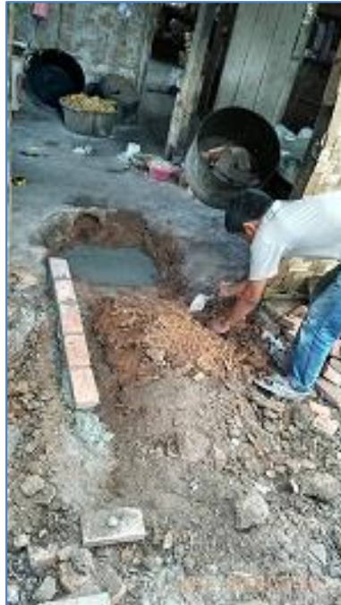
Gambar 4. Pembuatan fondasi tobong belakang Ket : pembuatan fondasi harus menggunakan water pass dan benang, sehingga akan memiliki permukaan yang datar.
