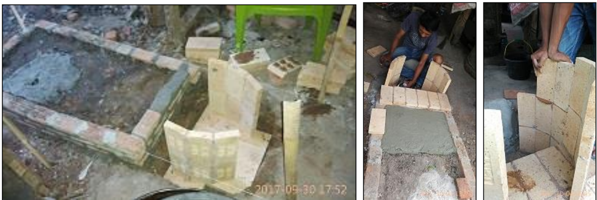
Gambar 5. Pemasangan dinding tobong depan
