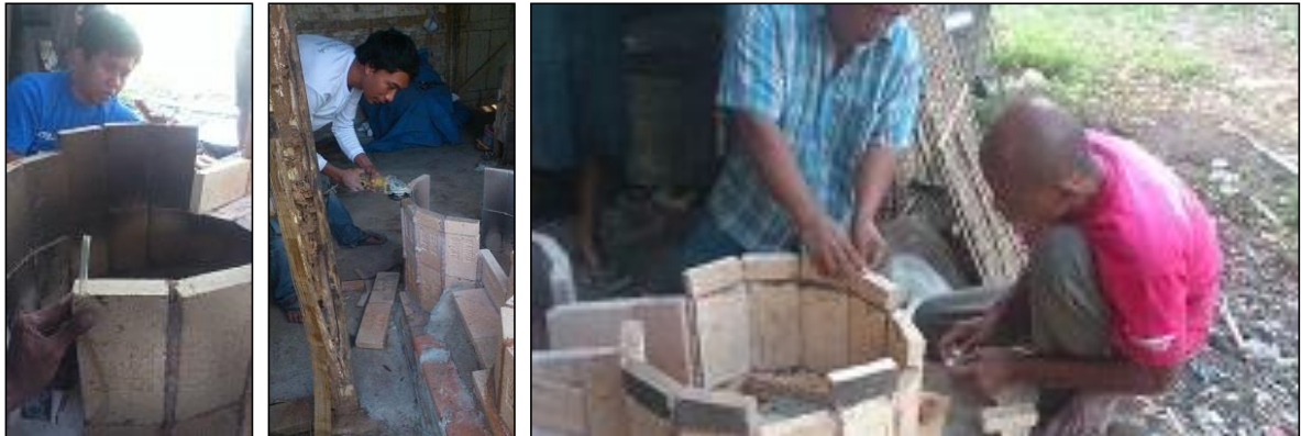
Gambar 9. Pemotongan dan penambahan ketinggian tungku sesuai keinginan mitra
