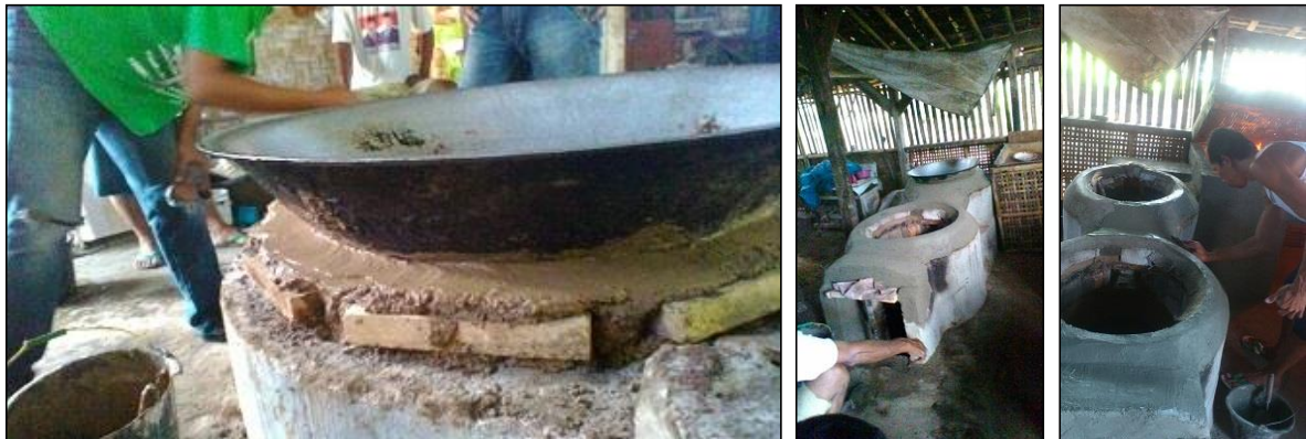
Gambar 14. Pembuatan dudukan wajan dari bata tahan api SK32, campuran castabel dengan tanah lempung, asbes karung api, dan ceramicwool
