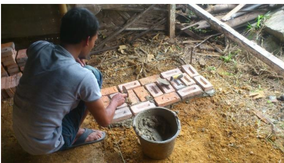
Pembuatan Pondasi Tungku sekaligus meninggikan posisi Tungku Penggorengan agar ergonomis, serta pemasangan Batu bata Tahan Api Awal
