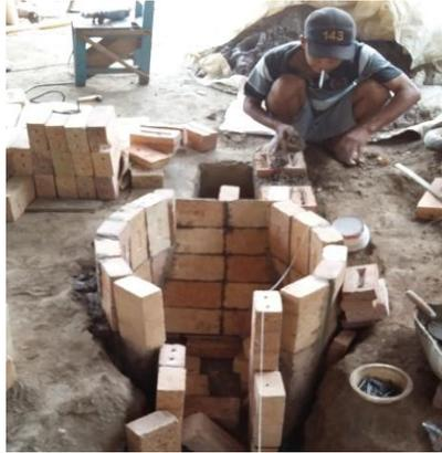
Gambar A9. Proses Pemasangan bata tahan api pada tobong pertama
