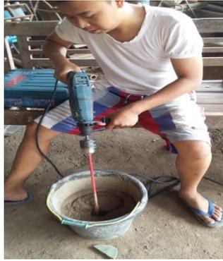
Gambar A19. Proses pengadukan campuran *castable* dan tanah lempung
