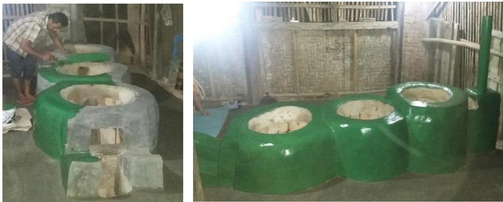
Gambar A22. Proses pengecatan (kiri) dan hasil pengecatan (kanan)
