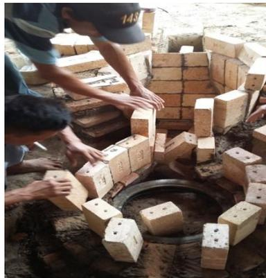
Gambar A10. Proses pemasangan bata tahan api pada tobong dua
