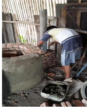
Gambar A17. Pemasangan cerobong asap
