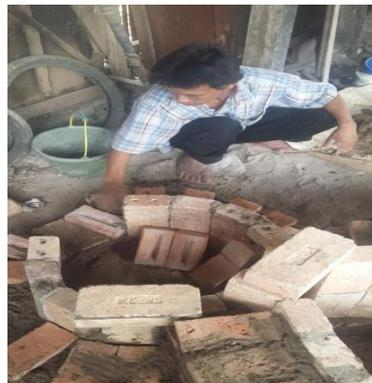
Gambar A11. Proses pemasangan bata tahan api pada tobong tiga
