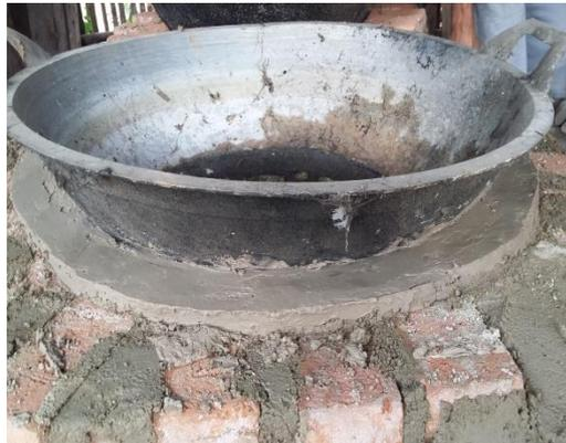
Gambar A20. Pembuatan mulut tungku
