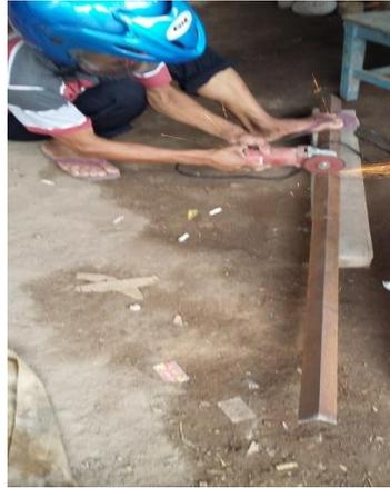
Gambar A15. Pemotongan besi siku
