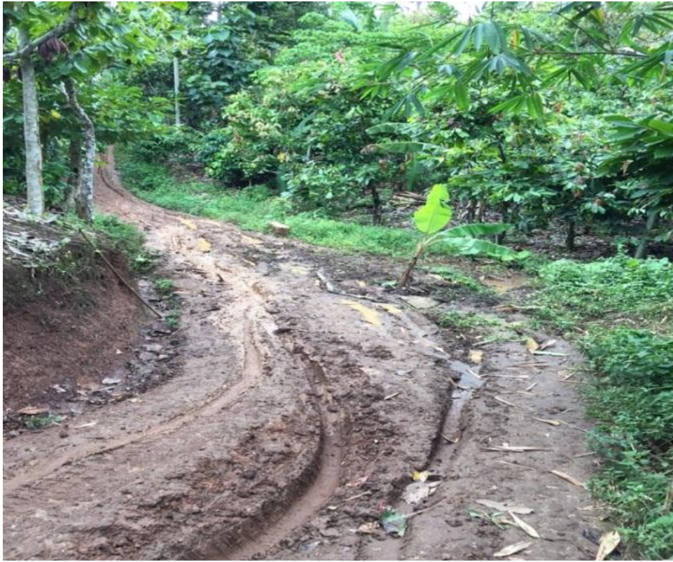
Gambar 2. Kondisi jalan menuju Dusun Sinar Jaya, Desa Bayas Jaya
