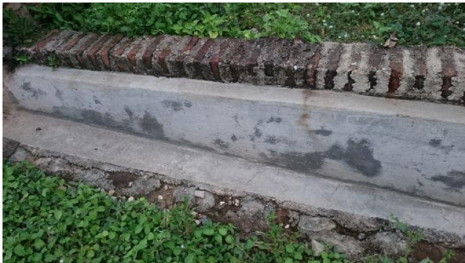
Gambar 5. Dinding dan dasar saluran dibeton
