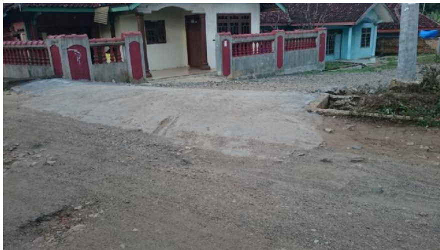
Gambar 8. Pengarah aliran berbentuk gundukan beton yang melintang di jalan
