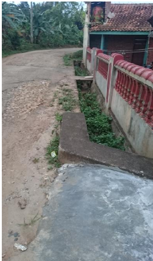
Gambar 7. Pengarah aliran yang berbentuk siku
