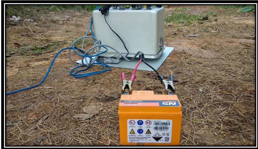
Gambar 6.6. Kabel power terhubung pada aki.
