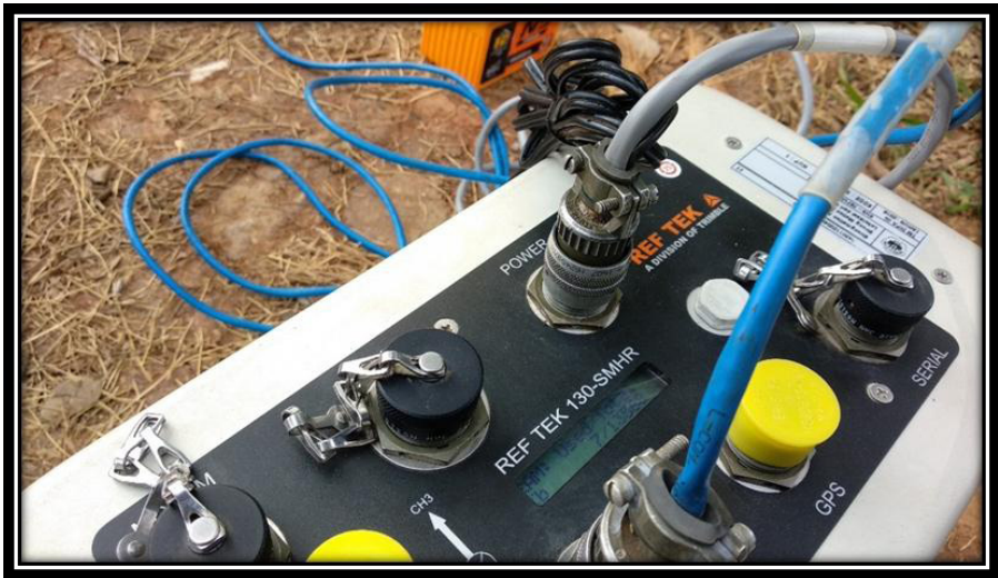
Gambar 6.7. Kabel power terhubung pada alat.
