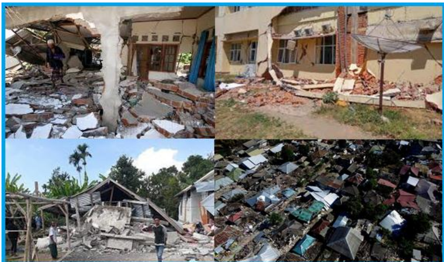
Gambar 8.2. Dokumentasi puluhan ribu bangunan mengalami kerusakan dan roboh akibat gempa berkekuatan 7 sr di lombok
