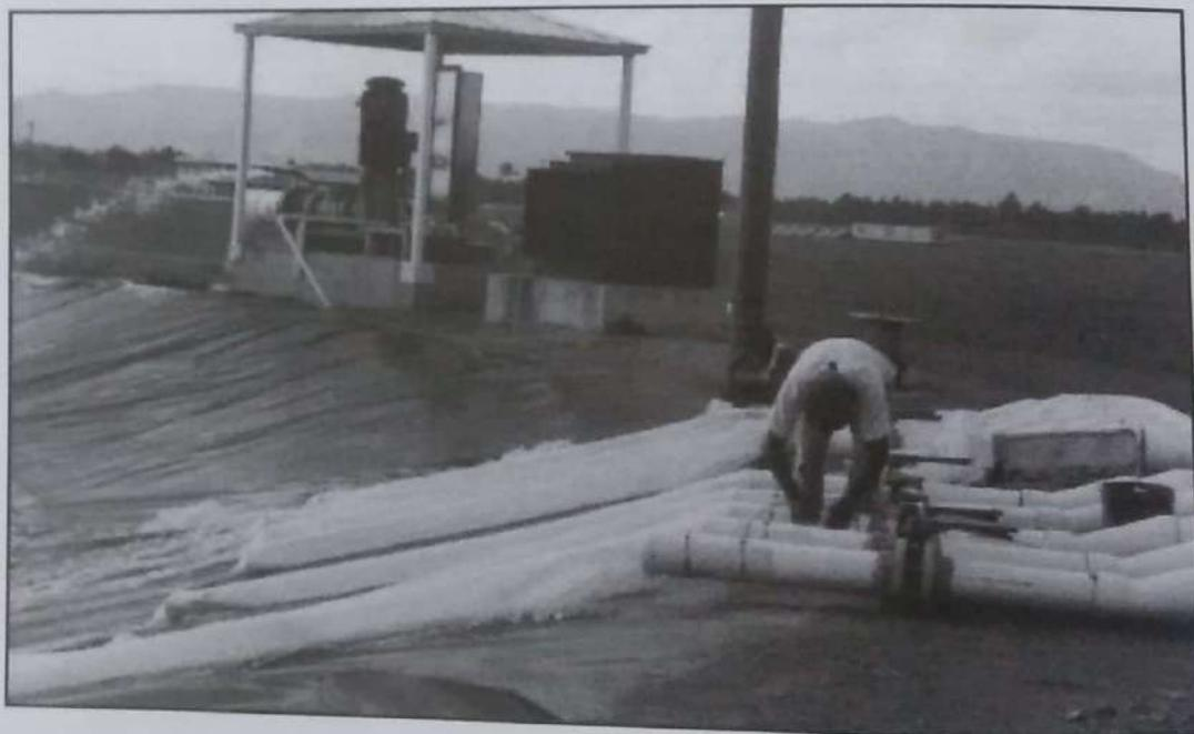
Gambar 10.5. Penyaringan dengan menggunakan strimin pada pipa pemasukan
