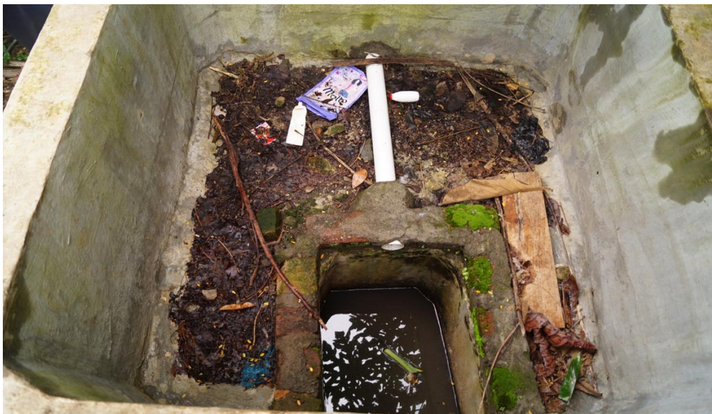
Gambar 4. Kedalaman kubah jauh dari ukuran yang telah ditetapkan.
