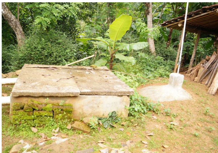
Gambar 2. Ukuran kubah tidak sesuai dengan ukuran seharusnya.
