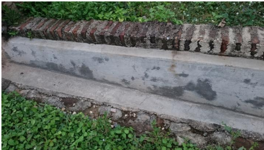
Gambar 5. Dinding dan dasar saluran dibeton
