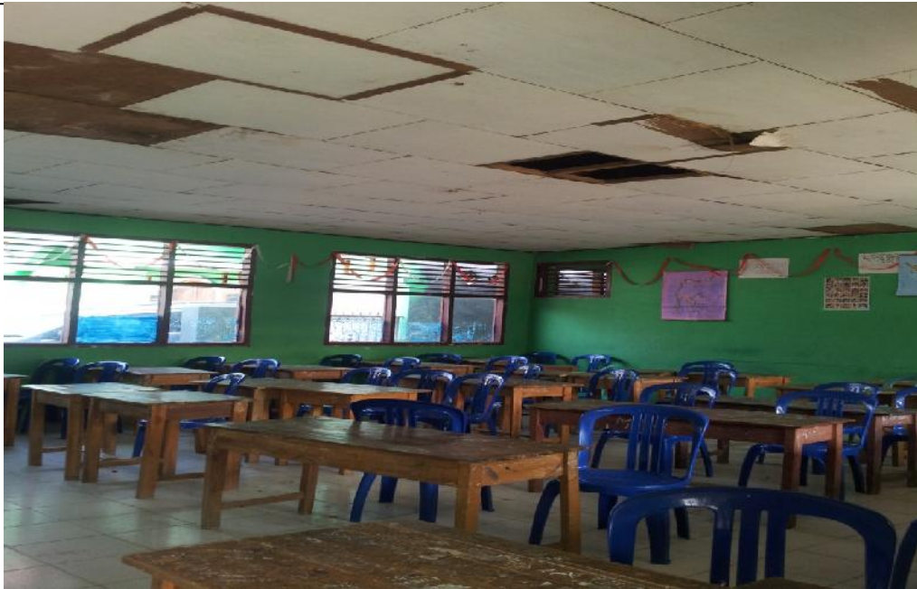
Gambar 4.3 Kondisi Ruang Kelas Secara Umum
