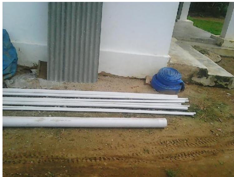
Gambar 4. Pipa untuk saluran pemasukan dan pengeluaran air
