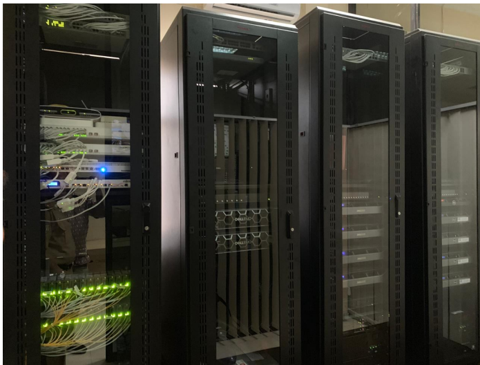
Server di Dinas Kominfo Kab. Pringsewu
