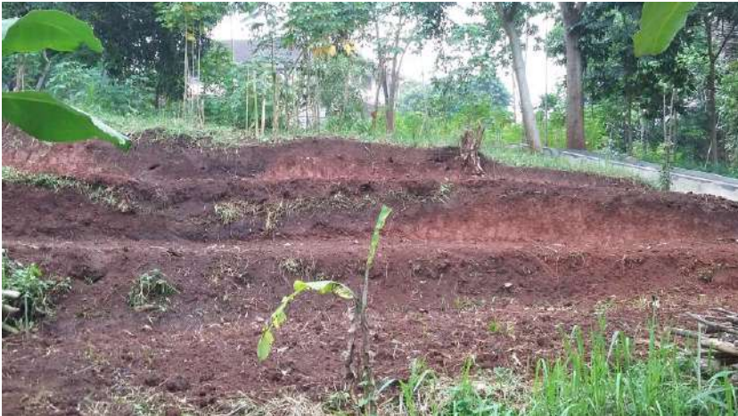
Gambar 28. Pembuatan teras bangku di areal Laboratorium Lapang Terpadu FP Unila
