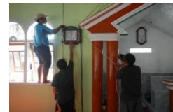
(b) instalasi di dalam ruang
