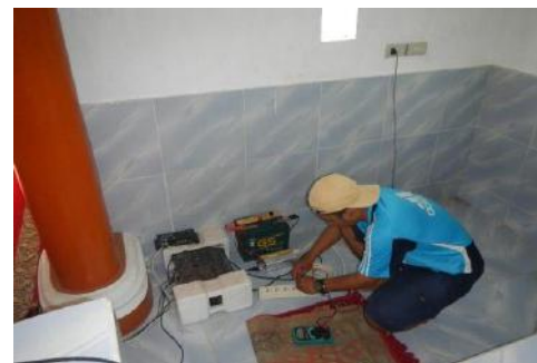
Gambar 3. Pengujian; mengukur besaran arus dan tegangan.
