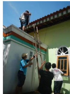
(a) Pemasangan panel surya
