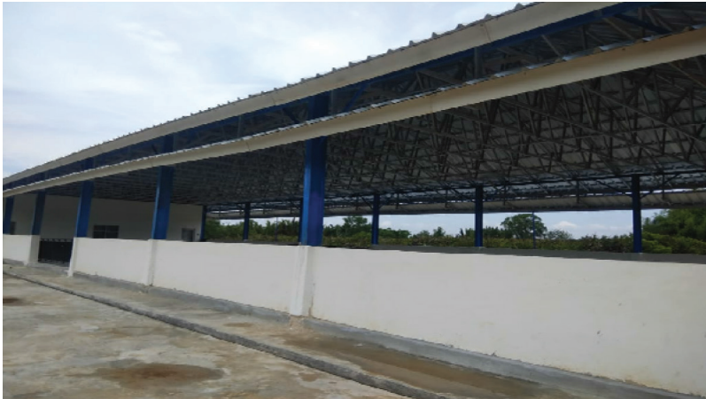
Gambar 4.8. Pembangunan Tempat Pelelangan Ikan (TPI) di Desa Sidang Muara Jaya
