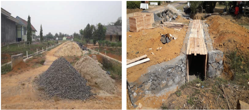
Gambar 4.1 Pembangunan jalan dan gorong-gorong di Desa Muara Tenang
