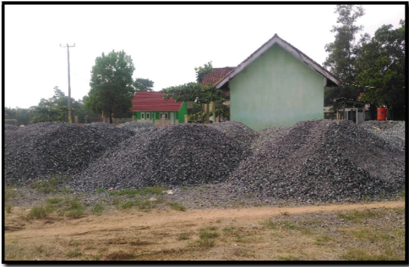
Gambar 4.4. Pembangunan jogging track di lapangan Desa Wira Bangun
