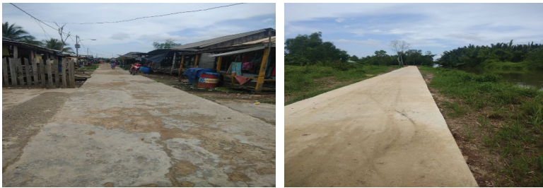
Gambar 4.9. Pembangunan Jalan Beton di Desa Desa Sidang Muara Jaya
