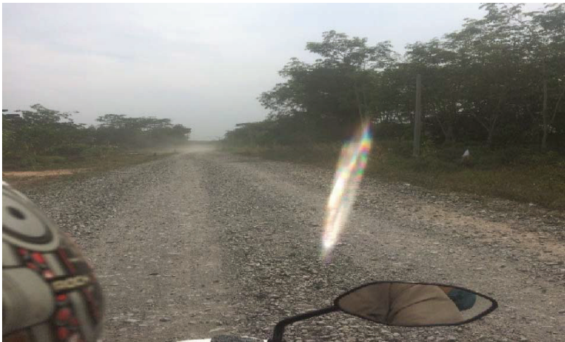
Gambar 4.3 Pembangunan Jalan Desa Bangun Jaya
