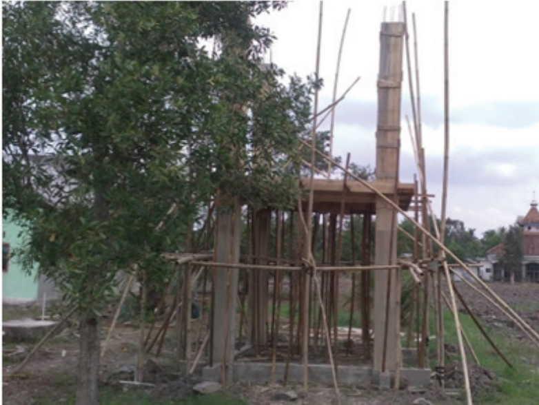
Gambar 3.18. Proyek Pembangunan PAMSIMAS di Desa Pangkal Mas Jaya
