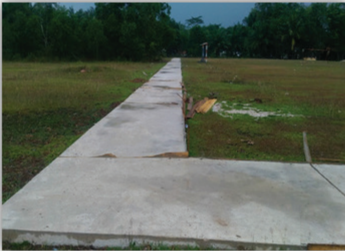
Gambar 3.17. Pembangunan jogging track di lapangan Desa Wira Bangun
