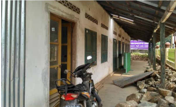
Gambar 4. Bangunan bekas Madrasah.
