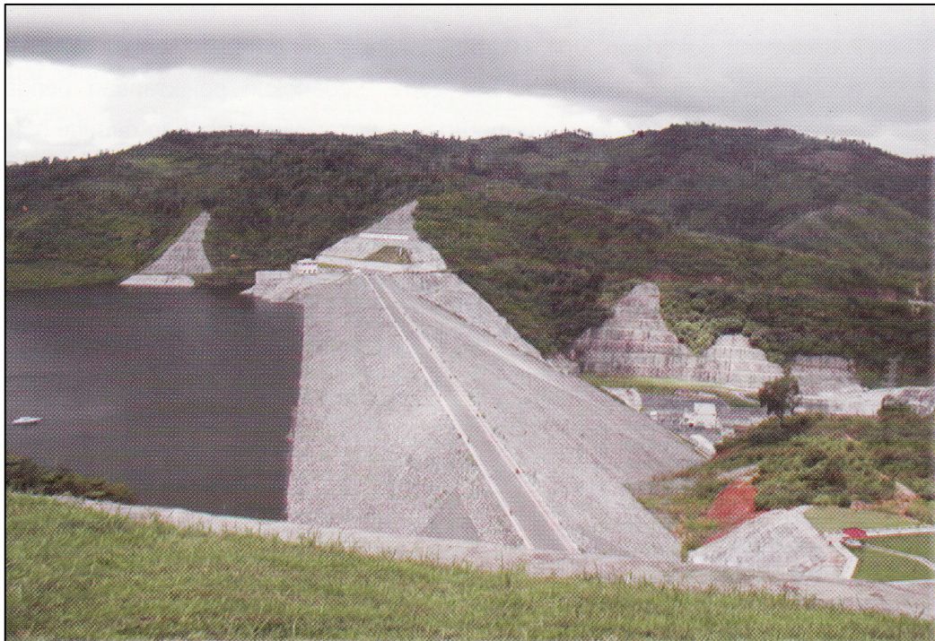
Gambar.2. Foto Tubuh Bendungan
