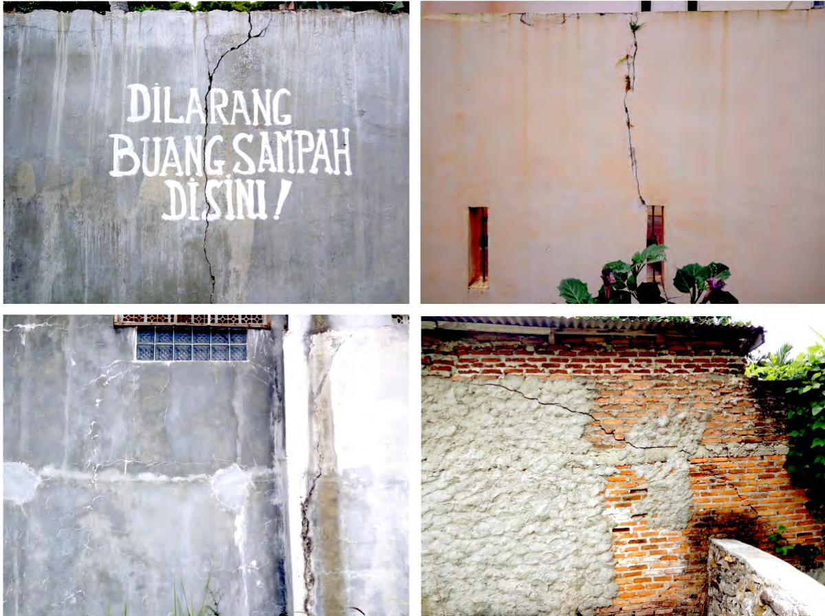
Gambar 10. Beberapa satu sampel kerusakan struktur bangunan akibat penurunan muka tanah di Daerah Bakung, Telukbetung Barat.
