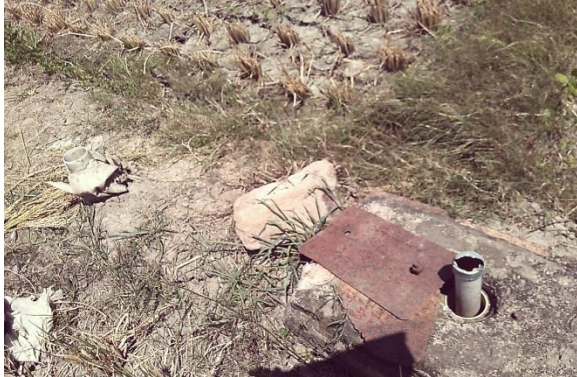
Gambar 2. Sumur bor dangkal yang sudah tidak ekonomis dari sisi operasional.
