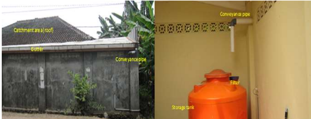
Gambar 2. Fasilitas pemanenan air hujan skala rumahtangga di Lampung Selatan
