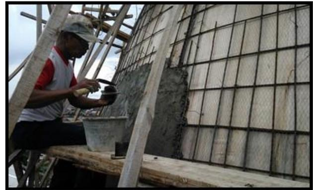
**Gambar 4.** Pemplesteran kubah dengan mortar
