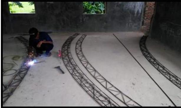
**Gambar 8.** Pembuatan kerangka rib kubah
