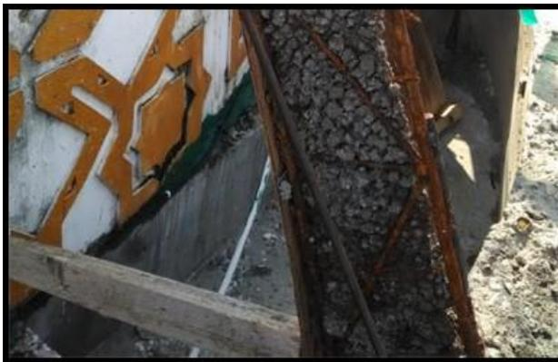
**Gambar 9.** Pemplesteran rib kubah dengan mortar
