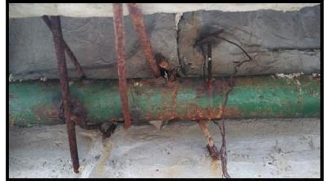
**Gambar 2.** Korosi pada kerangka pipa baja penopang kubah GRC
