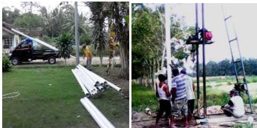
Gambar 3. Pengadaan pipa paralon dan pemasangan pompa
