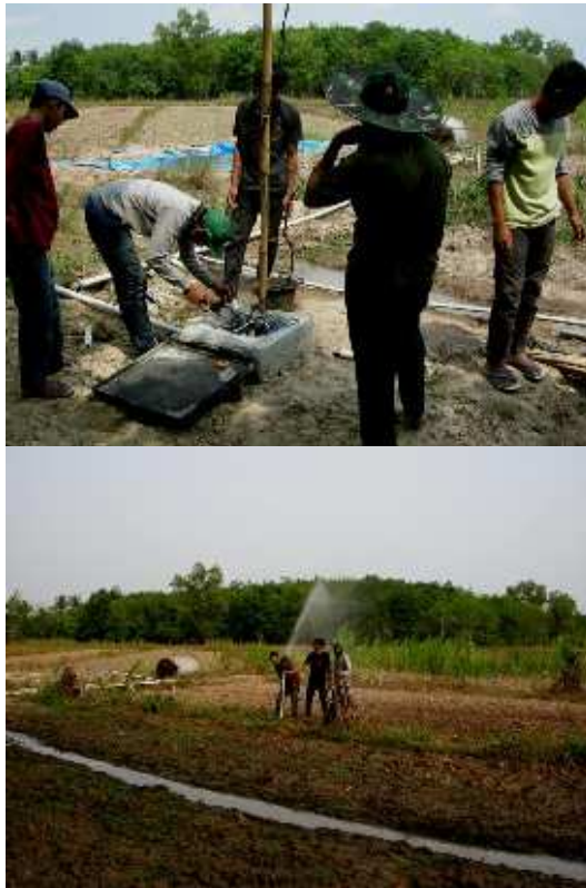
Gambar 4. Pemasangan dan uji-coba sprinkler
