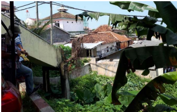
Gambar 7. Kondisi Tapak berada di kontur terendah dan Kondisi Jaringan Listrik berada melintang di atas tapak. Sumber: Dokumentasi Tim PKM, 2018
