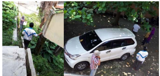
Gambar 6. Kondisi saluran pembuangan air hujan dan Ruang Parkir. Sumber: Dokumentasi Tim PKM, 2018.
