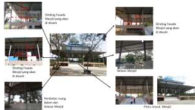
Gambar 3 Fasade Masjid yang akan dilakukan pemasangan Bambu (survey, 2018)
