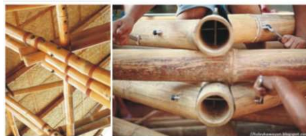
Gambar 1 Koneksi Baut Bersendi dan Injeksi Mortar Pada Bambu (Harysakti, Ave, dkk. 2014)
