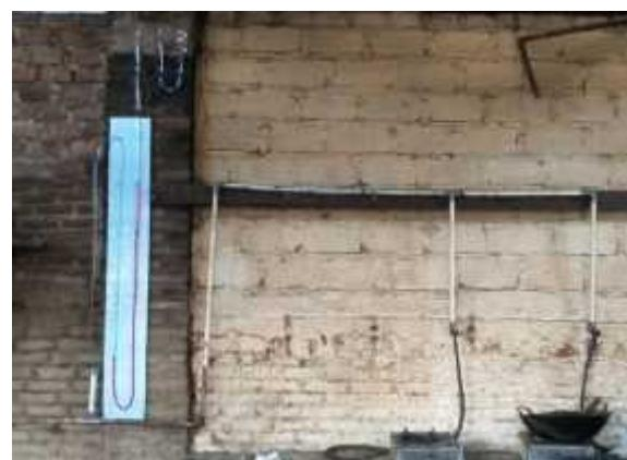
Gambar 6 Pemasangan manometer U
