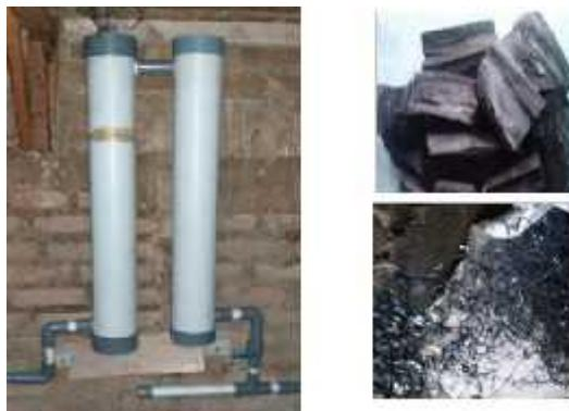
Gambar 8. Tabung filter biogas yang berisi arang dan geram besi
