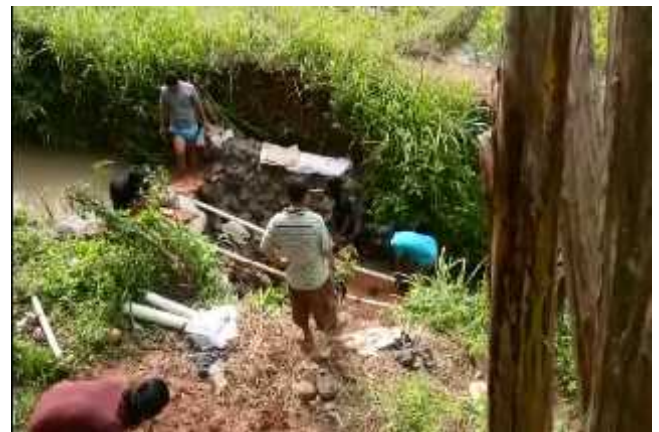
Gambar 6. Pembuatan bendungan sebagai sumber aliran penggerak pompa tanpa motor.
