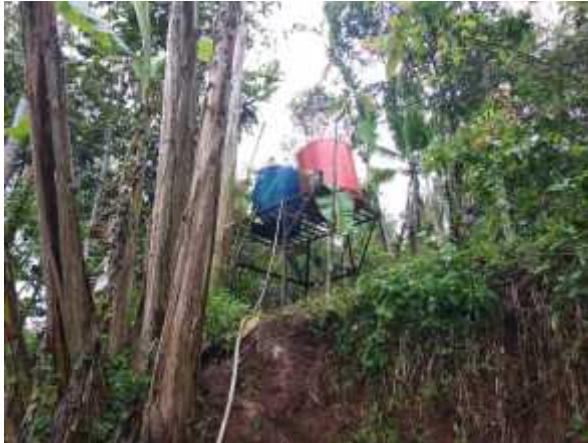
Gambar 8. Sistem irigasi pompa tanpa motor ( hydrum pump ) yang dibangun.
