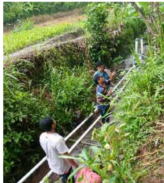
Gambar 7. Pemasangan pompa tanpa motor ( hydram pump ) pada pembangunan sistem instalasi irigasi dilokasi.
